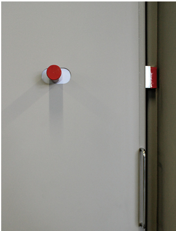
Tür geschlossen und von innen mechanisch verriegelt
