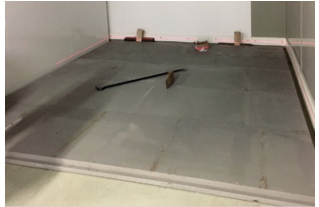
Verlegung des Modulraum-Bodens
